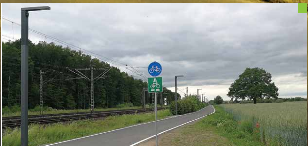
RADSCHNELLWEG FRANKFURT AM MAIN // DEUTSCHLAND / GERMANY
